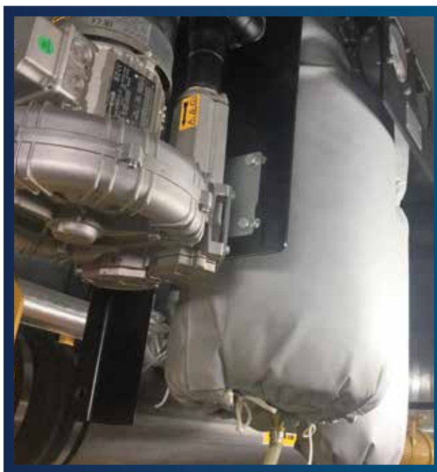
ACVB-Installation mit Isolierdecke
